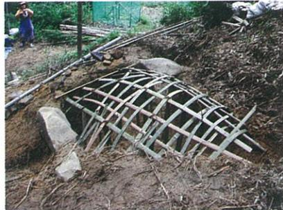
写真1 天井架設作業のようす
